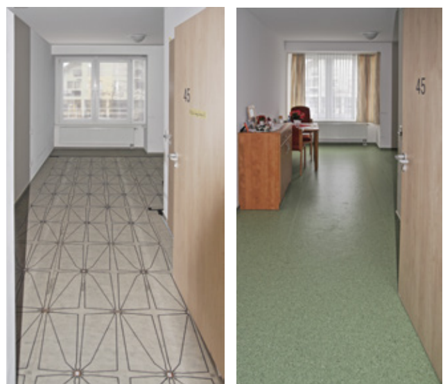
Der SensFloor wurde unter dem PVC-Boden verlegt
